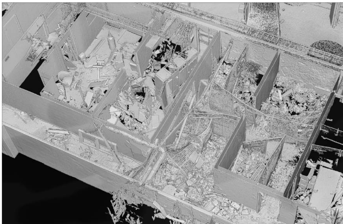
Figur 1. 3D-modell av källare efter en större explosion.
